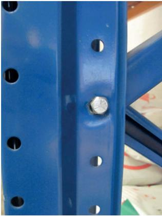
Figura 3.8 Falla conexión riostra-pilar en marco
