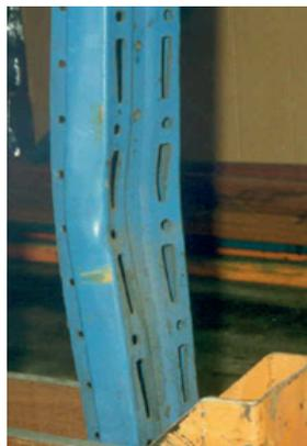
Figura 3.14 Pilar con abolladura por colisión con grúa
