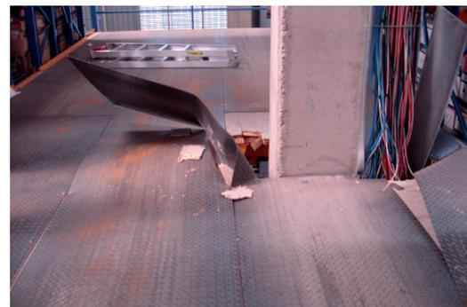
Figura 3.11 Choque de rack con pilar estructural del edificio
