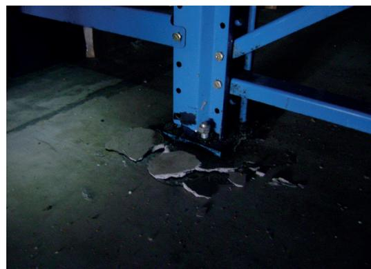
Figura 3.10 Falla del hormigón en la base
