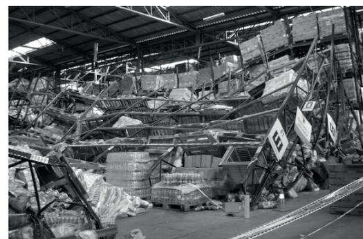
Figura 3.13 Colapso de rack
