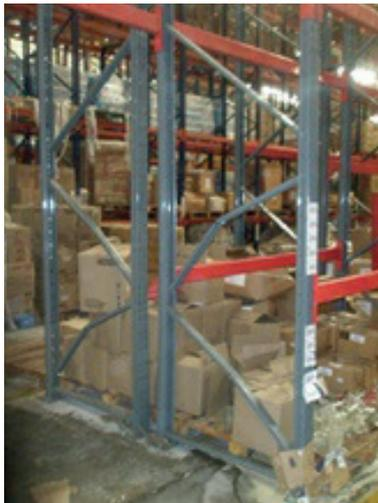
Figura 3.3 Pandeo por flexión en las riostras inferiores de un rack
